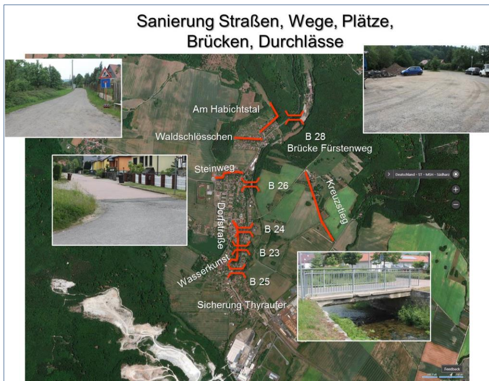
Abbildung 78: Sanierungsbedarf Straßen und Brücken im OT Rottleberode
