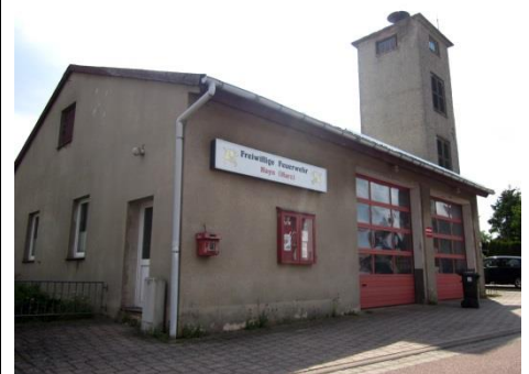
Gerätehaus Freiwillige Feuerwehr
