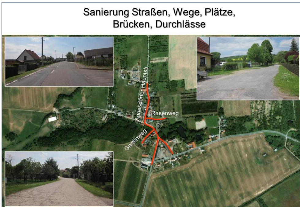
Abbildung 54: Sanierungsbedarf Straßen und Brücken im OT Agnesdorf
