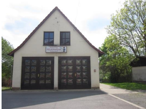
Gerätehaus Freiwillige Feuerwehr
